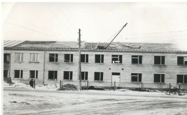
Строительство роддома. 1985г.
